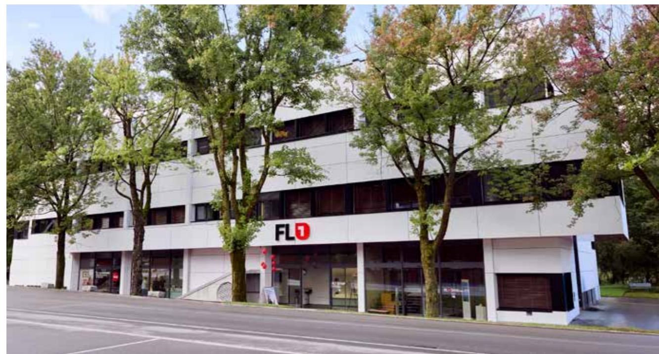
Energetische Sanierung der Gebäudehülle und FL1 Shop neu seit September 2025 an der Schaanerstrasse
