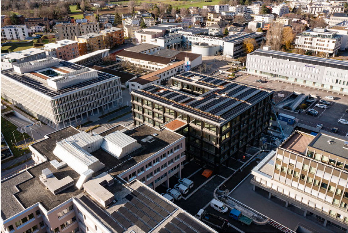
Das neue Bürogebäude komplettiert den LLB Campus in Vaduz.
