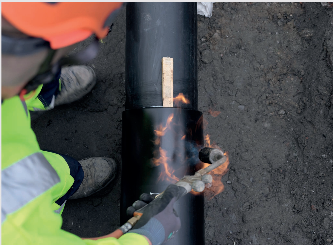
Fernwärmeleitung, Vaduz (Rohrleitungsbau)
