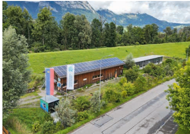
Abb. 58 Fischzuchtanlage in Ruggell (Fotos: Rainer Kühnis)
