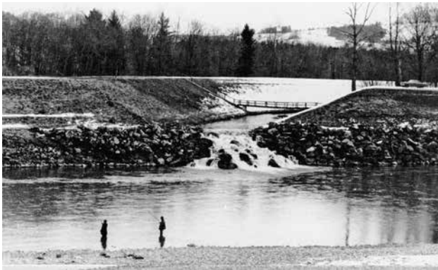
Abb. 51 Mündungsbereich des Liechtensteiner Binnenkanals vor und nach der durchgeführten Revitalisierung. (Quelle: Archiv des Fischereivereins Liechtenstein.)
