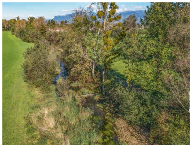
Abb. 55 Revitalisierter Abschnitt des Mölibachs unterhalb Ruggell (Foto: Hydra)
