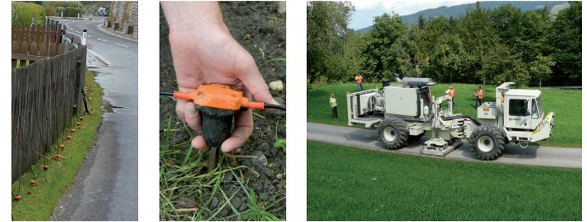
Die Geophone werden entlang der Messlinie ausgelegt.
