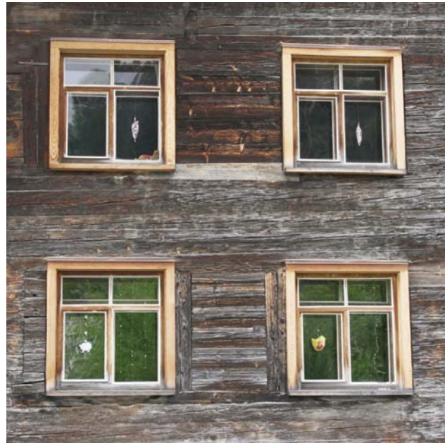
Verleimung von Fensterflügeln Fenster (Fichte) EFH Schellenberg
