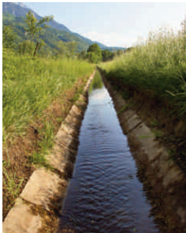
Abb. 21 Ein hart verbauter Entwässerungsgraben beim Er-lenbach
