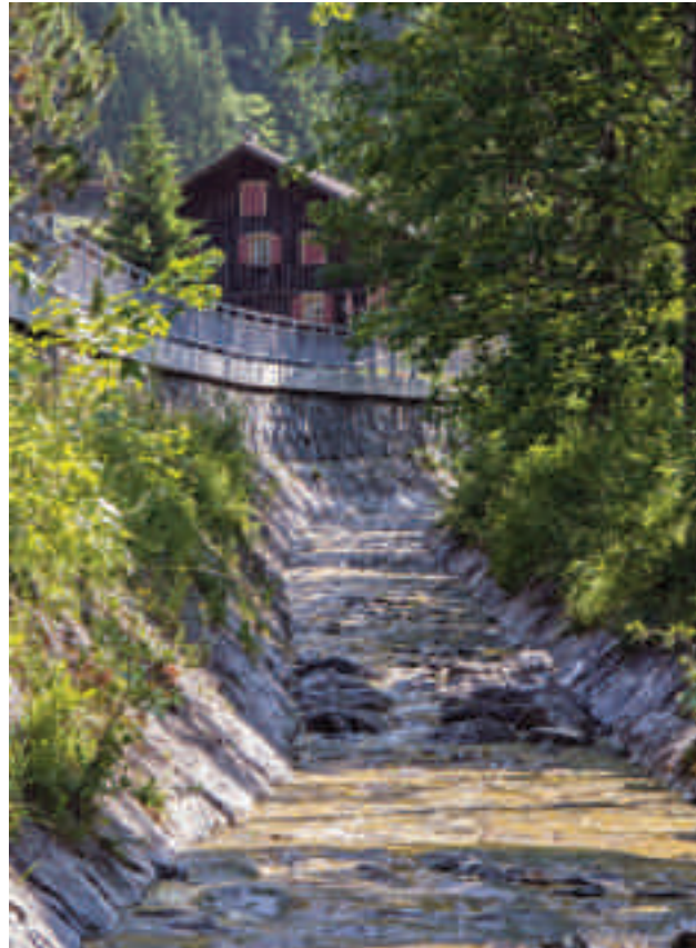
Abb. 21 Ein hart verbauter Entwässerungsgraben beim Er-lenbach
