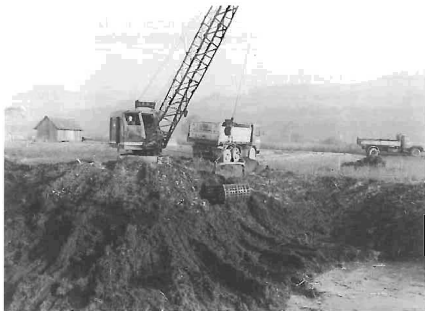
Aushubarbeiten für neuen Weiher 1982.
