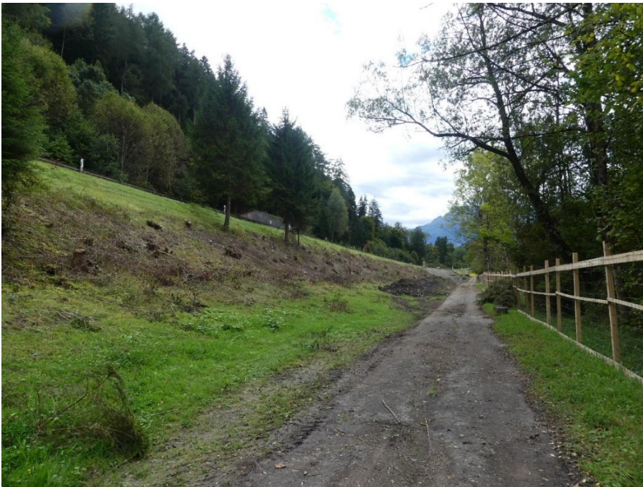
Abb. 8: Foto-Standort Alte Landstrasse, zwischen Unterführung und Überführung, Blickrichtung Nord-Süd. Ca. in Bildmitte die bestehende Stützmauer, die als Widerlager der Überführung dienen soll.
