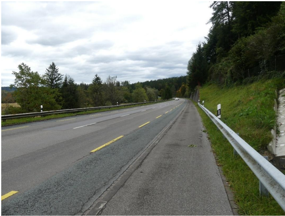
Abb. 9: Foto-Standort Landstrasse, Blickrichtung Süd-Nord, rechts hinten die Stützmauer, welche als Widerlager der Überführung dienen soll.
