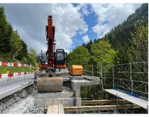
Mit einer Lichtsignalanlage kann der Verkehr jederzeit einspurig entlang der Baustelle geführt werden. Da keinerlei Umfahrungsmöglichkeiten vorhanden sind, müssen sämtliche Arbeiten halbseitig ausgeführt werden. Dies führt zu insgesamt 6 Bauetappen.
