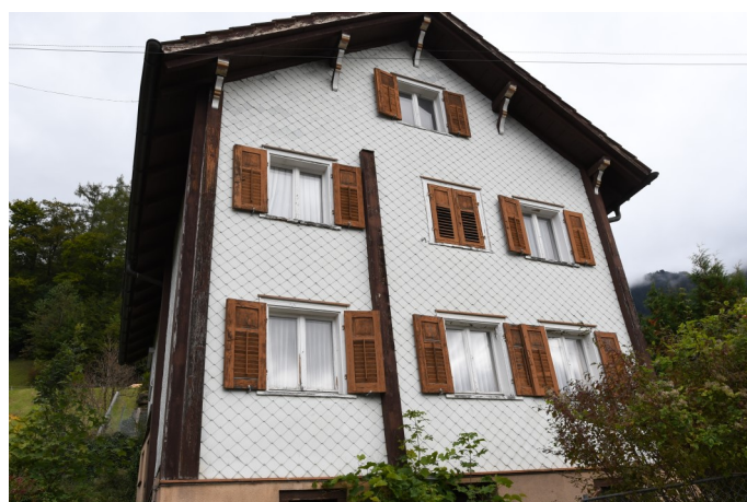
Abb. 1: Triesenberg, Sennwisstrasse 27, Südwestecke, Detail der Balkenlagen des 1580 datierten Blockbaus.
