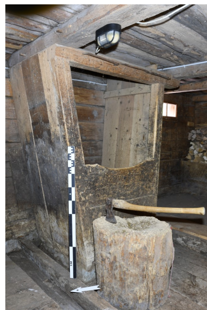
Abb. 2: Detail des Heuabwurfs an der Ostwand des Stalls.
