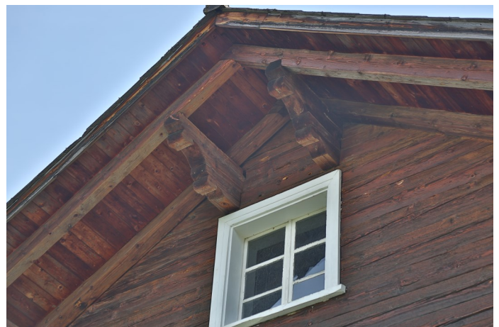
Abb. 3: Pfettenköpfe und zusätzliche Konsolbalken zur Hauptfassade mit dekorativem Sägeschnitt.
