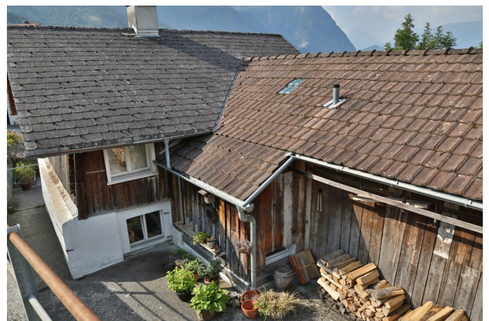
Abb. 6: Stallscheunenbau von 1911, Nordansicht.
