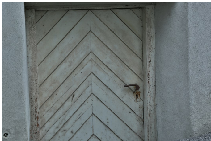
Abb. 3: Kellertür in Gestaltung und Fertigung von 1799.
