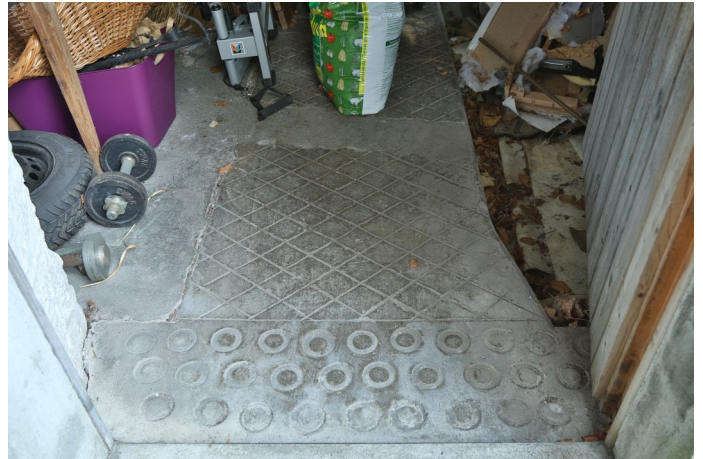
Abb. 5: Bauzeittypische Texturen in der Oberfläche des Betongussbodens von 1909.
