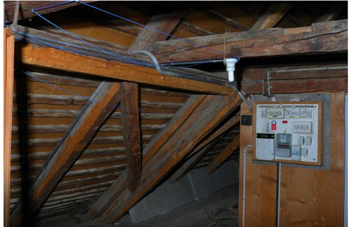
Abb. 4: Dachgeschoss mit Dachstuhlbinder von 1829 in liegender Art, rechts Firstkammereinbau.
