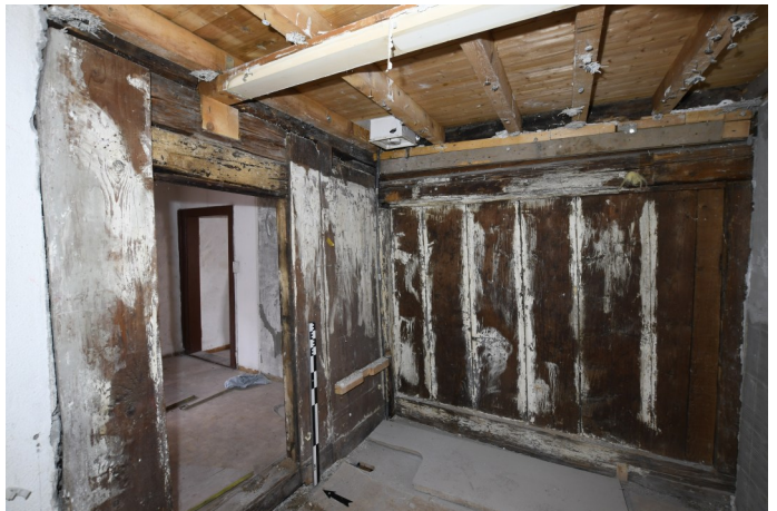
Abb. 2: Schaan, Winkelgass 2. Hinterhaus. Übersicht mit den freigelegten Ständerwänden und Bretterfüllungen. Blick Richtung Nordosten.
