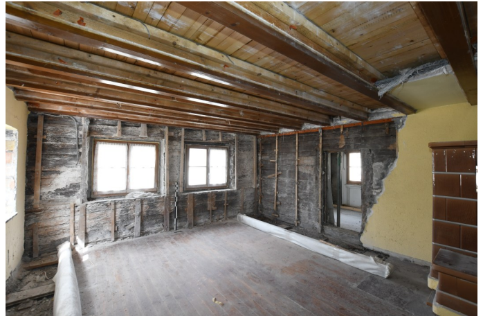
Abb. 1: Schaan, Winkelgass 2. Vorderhaus, Übersicht Stube. Blockkonstruktion von 1589d. Blick Richtung Nordwesten.
