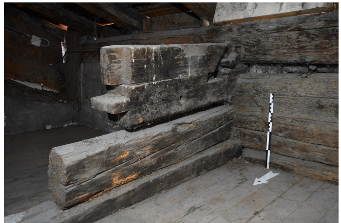
Abb. 4: Schaan, Winkelgass 2. Hinterhaus, Dachgeschoss. Detail der Stummelwand mit wiederverwendeten Hölzern. Blick Richtung Südosten.
