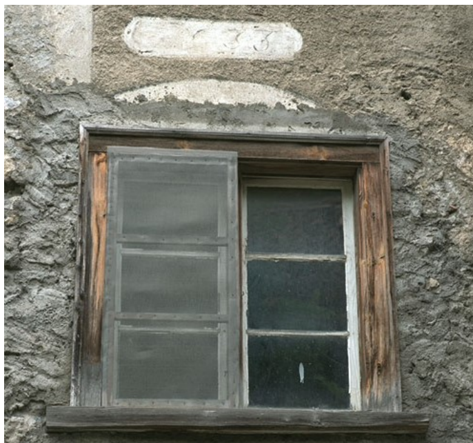
Abb. 4: Höfle 32, Ostfassade: Lisenenbemalung, weiss gefasste stichbogige Türöffnung vor 1862 und darüber alte Hofstätten-Nummer 33 auf weissem Grund.
