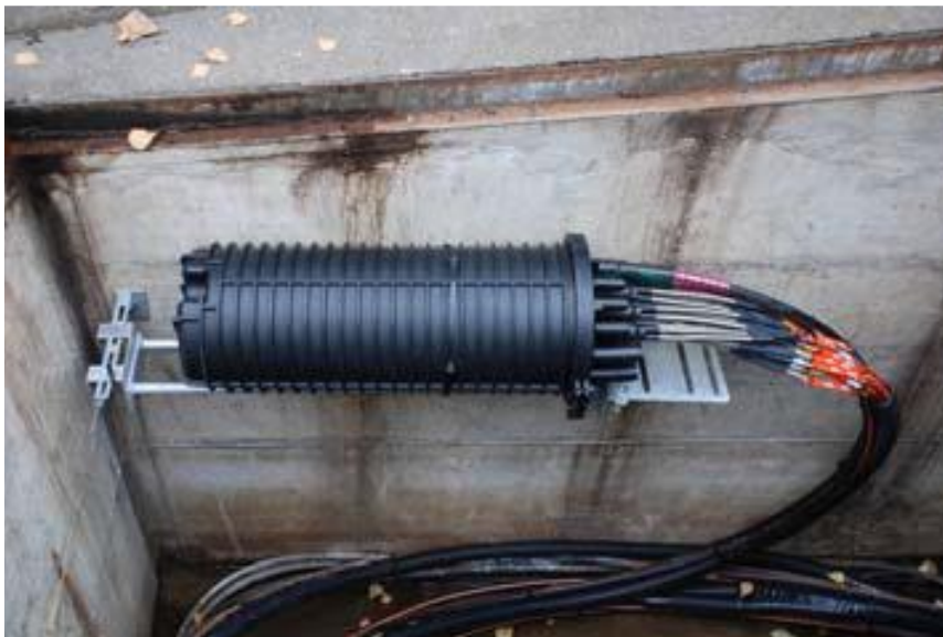
Abbildung 21 Kabelkanalisation: Platzierung Spleissmuffe
