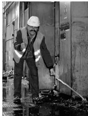
Bild 1: Mit den Rückbauarbeiten erst dann beginnen, wenn die Bestätigung vorliegt, dass alle Werkleitungen ausser Betrieb sind.
