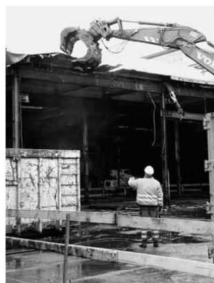
Bild 3: Die Gefahrenzonen entweder absperren und durch Warntafeln kennzeichnen oder durch Warnposten gegen Betreten sichern.
