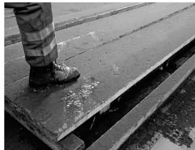
Bild 4: Vorsicht bei Abdeckungen, Gitterrosten, Blindböden usw. Es besteht Durchbruchgefahr.
