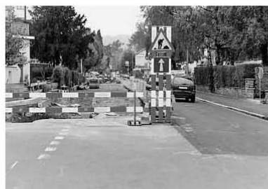
Bild 2: Korrekt signalisierte Baustelle.
