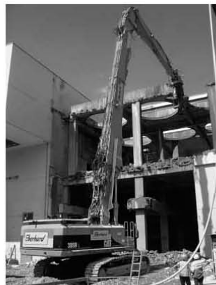
Bild 2: Bei maschinellern Rückbau dürfen sich keine Personen im Abbruchobjekt aufhalten.
