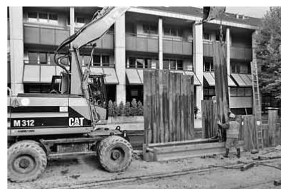
Bild 8: Sicherer Einbau von Spiessen.
